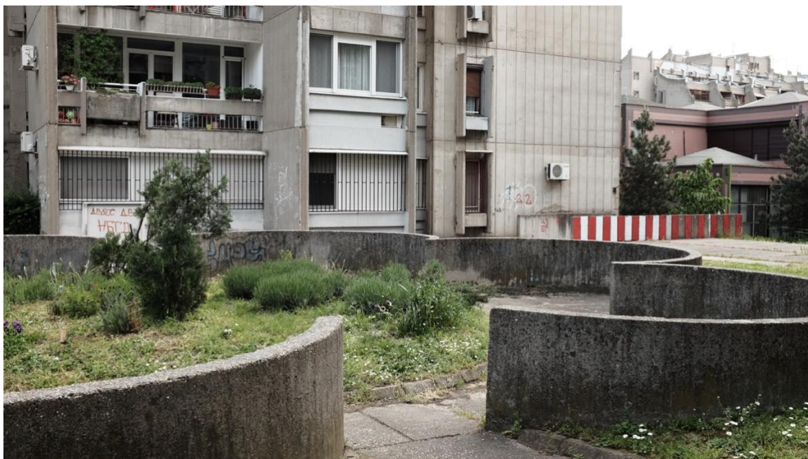
Ilustracija 42 „Cvetić“ na krovu podzemne garaže u čijem središtu su stanari posadili lavandu, ruzmarin i lale.
