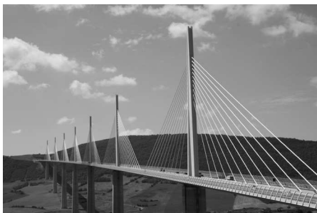
Сл. 5. Millau Viaduct , 2004. Француска
